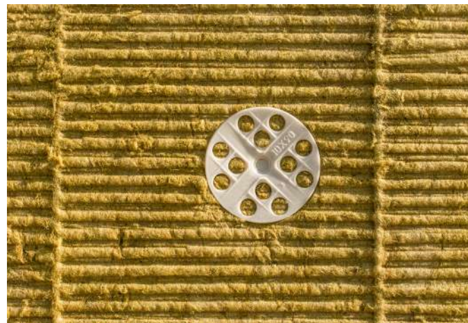
Beispiel eines richtig montierten Befestigungselements
