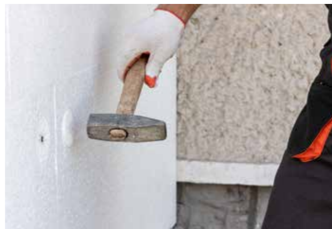
Beispiel eines richtig montierten Befestigungselements
